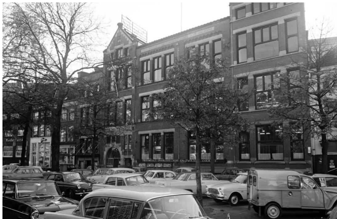
Het Tijlgebouw aan de Melkmarkt, 1967. Links zijn de in 2015 gesloopte Tijlpandjes, met middeleeuwse kern, en een stukje van het toen eveneens gesloopte bankgebouw (Amsterdamse school!) zichtbaar. (Foto Hen- neke, collectie HCO)
