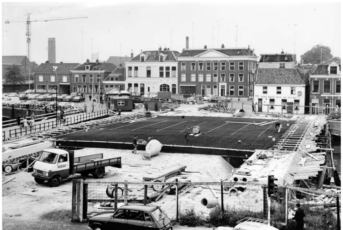
Aanleg van de Kamperpoortenbrug begin jaren zeventig, gezien richting Kamperpoort.
