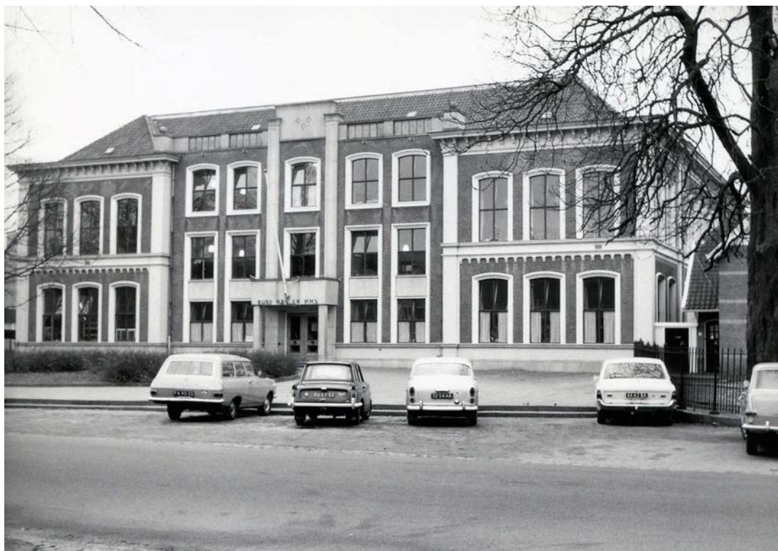
Het schoolgebouw aan de Bagijnensingel vlak voor de verhuizing van de Rijks HBS naar de Lassuslaan. Docenten mochten hun auto's voor het gebouw zetten. (Collectie HCO)
