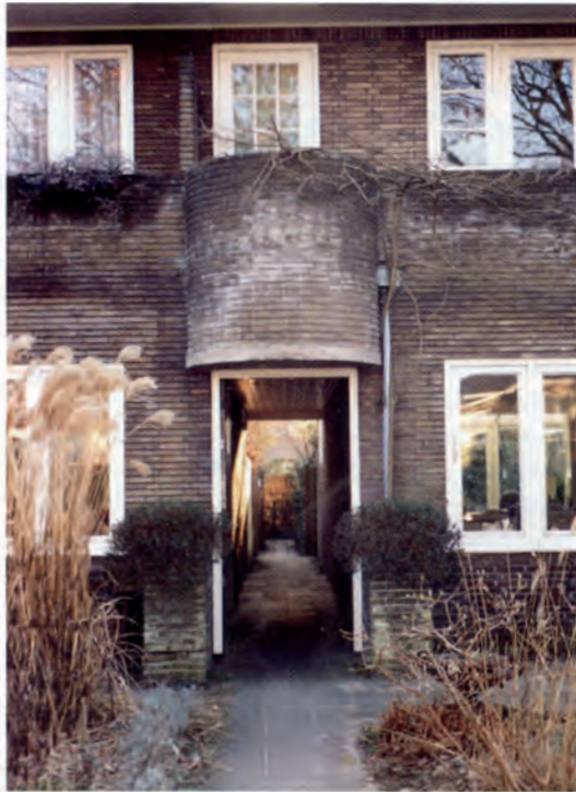
Gangpad tussen de huizen aan de Wipstrikkerallee 102-126. (Foto auteur)
