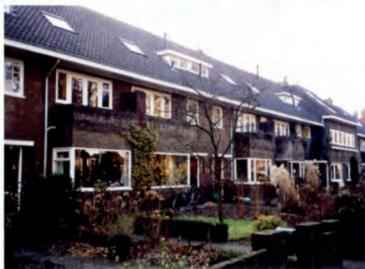
Gedeelte van het blok woningen Wipstrikkerallee 102-126, uit 1934. (Foto auteur)
