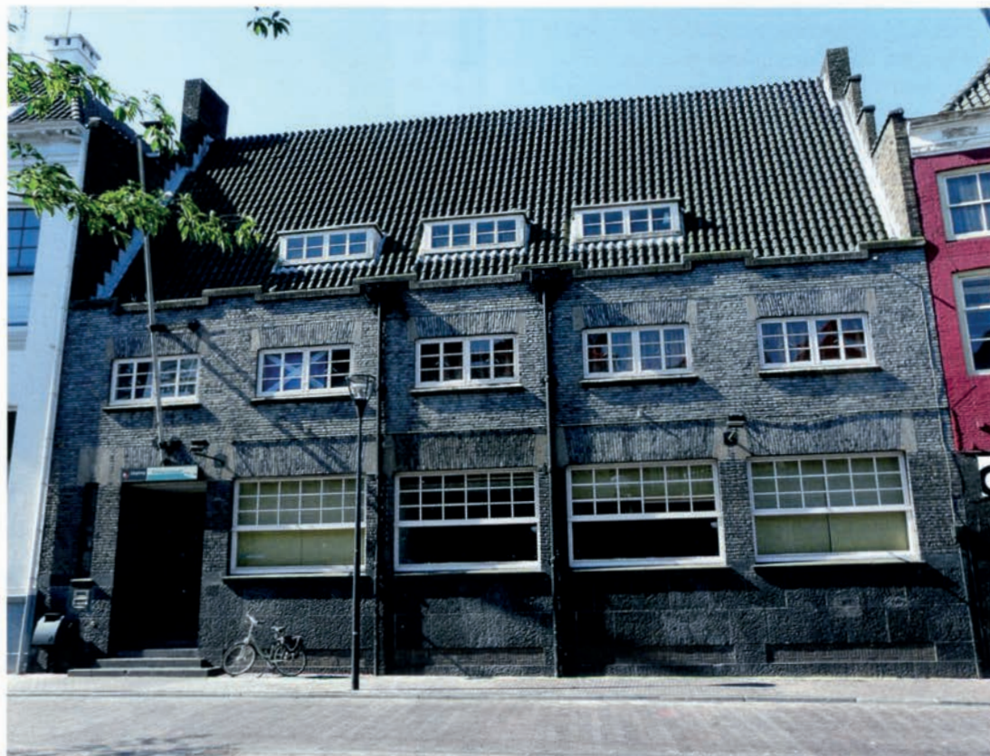
Het voormalige bankgebouw Van Straaten aan de Melkmarkt 1-5 in 2008. (Foto auteur)
