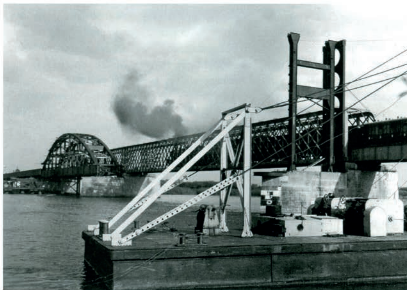
Boven: Aankomst van de vaste brugliggers in Zwolle. De liggers zijn bevestigd op tijdelijke ondersteuning op een dekschuit. Opname van 11 juni 1934. (Archief NS, Utrechts Archief)
