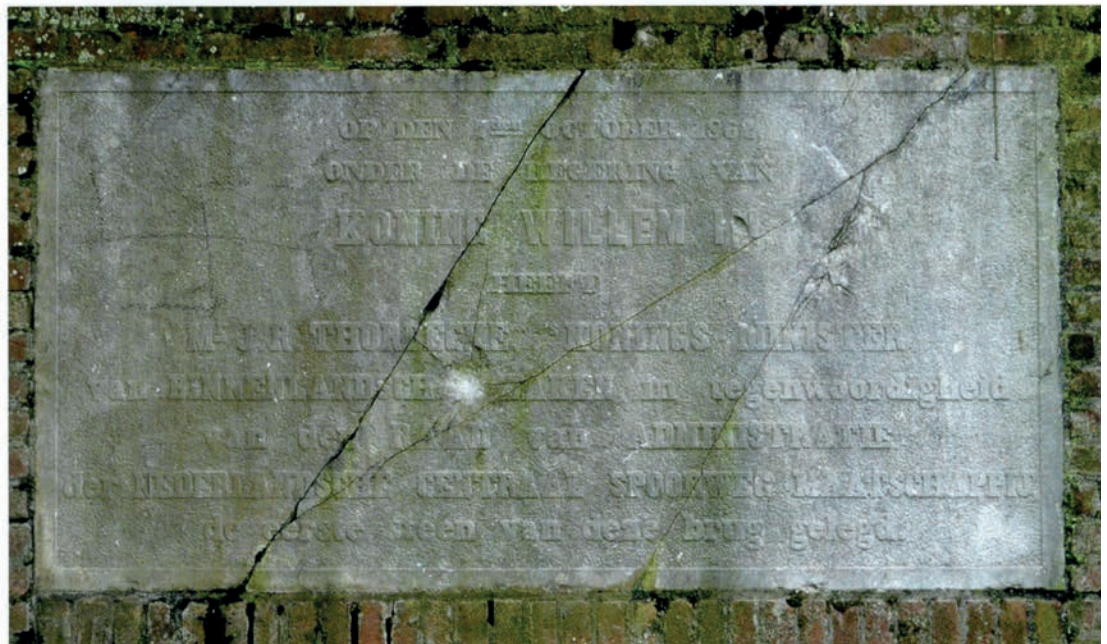
De gedenksteen van de eerste steenlegging op 7 oktober 1862 door minister Thorbecke in het landhoofd aan de Hattense zijde. (Foto M. Overbeek)
