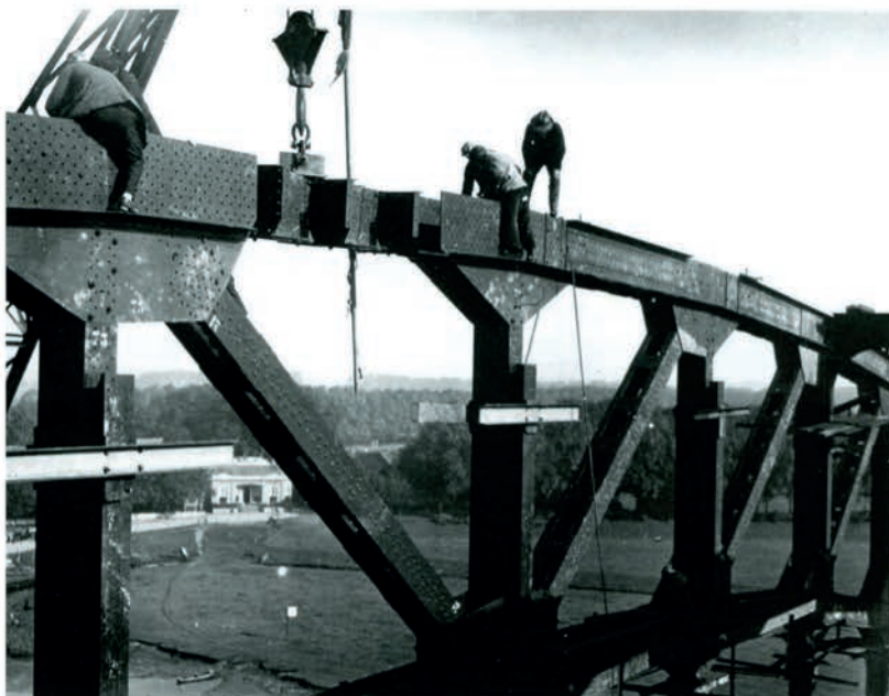
De bouw (1929) van de verkeersbrug over de IJssel. De arbeiders klonken de brugonderdelen op een hoogte van veertig meter boven het water aan elkaar, zonder verdere veiligheidsmaatregelen als touwen of onder de werkplek gespannen netten. (Collectie HCO)
