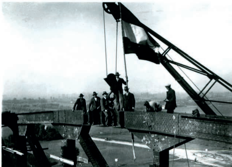
De vlag in top tijdens de bouw van de verkeersbrug over de IJssel, 1929. (Collectie HCO)
