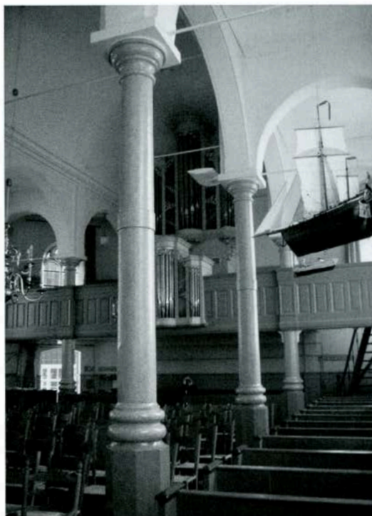
Interieur Nederlands-hervormde kerk te Marken met gietijzeren zuilen, 1904 (Foto M. Overbeek)
