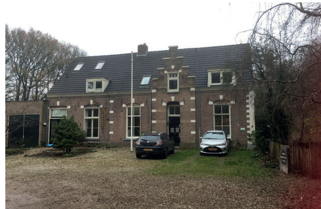
De voormalige Openbare Lagere School op Bergklooster in 2020, gelegen naast het kerkhof. (Foto Annët Bootsma)
