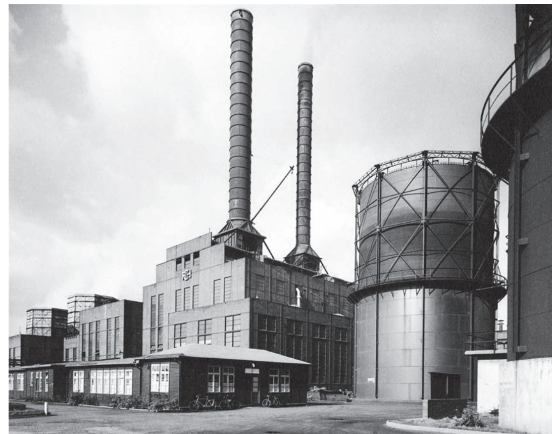
Het bedrijf Ruhrchemie in Oberhausen-Holten in 1938. (Foto Albert Renger-Patzsch)
