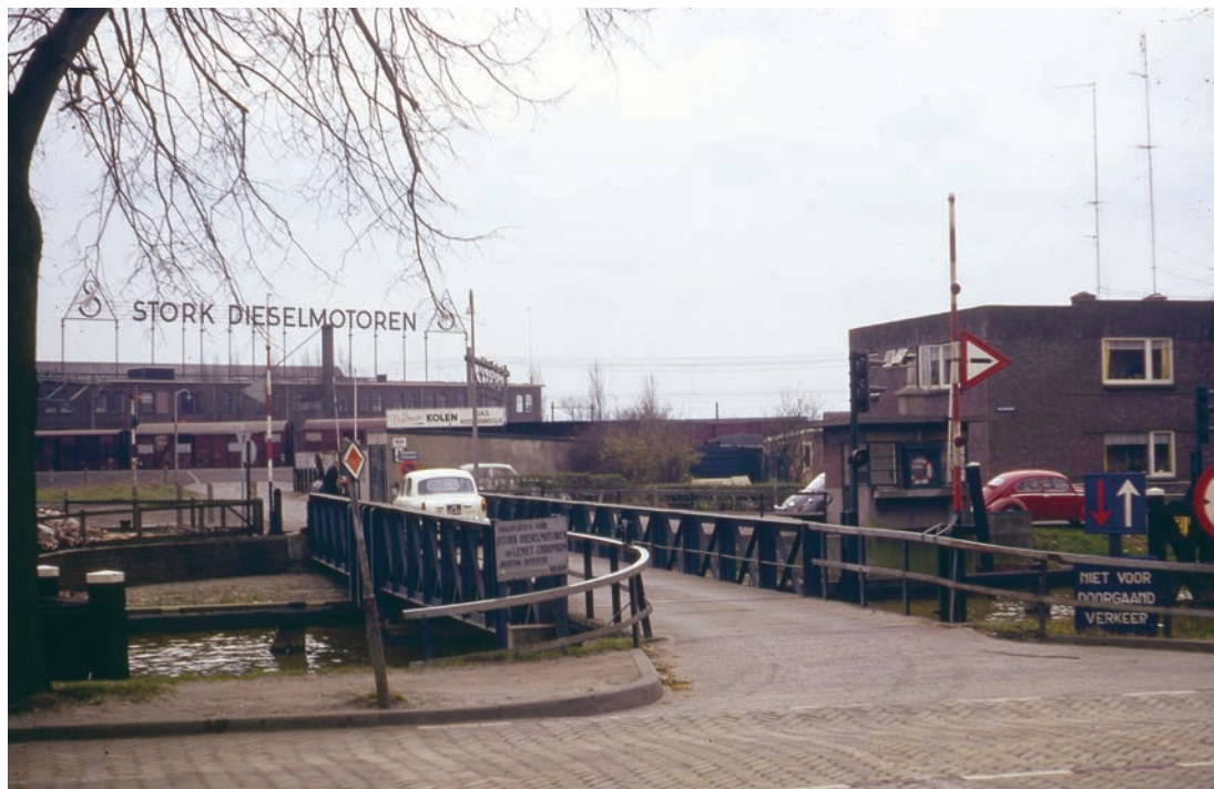
De Veeladingbrug bij de spoorhaven en het spooremlacement in 1967. (HCO, archief Vrienden van de Stadskern)
