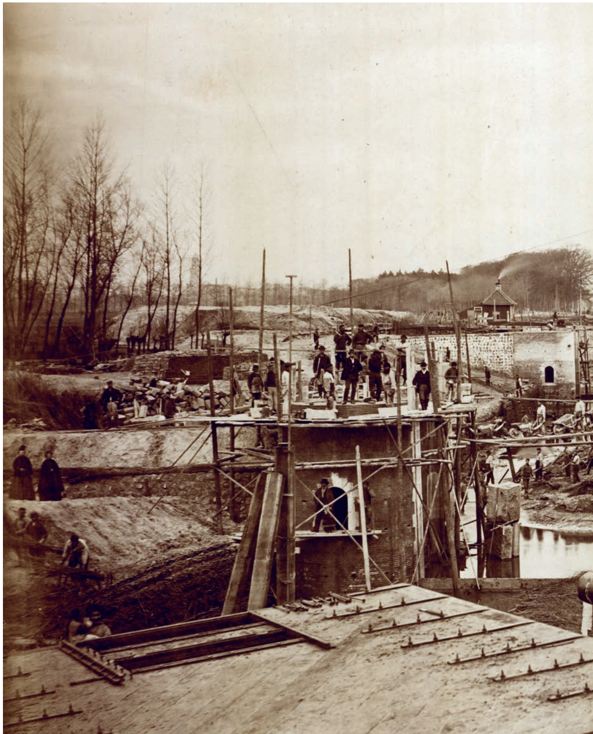
Het werk vordert. Hier gezien vanaf de buitensluis van het nieuwe sluiscomplex. Op de voorgrond liggen de sluisdeuren al klaar. (Foto F.W.H. Deutmann, HCO, Museale Collectie Zwolle, ds. 53)
