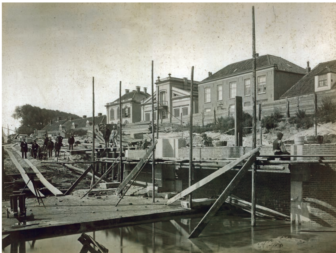
De aanleg van de nieuwe aansluiting van de Willemsvaart op de stadsgracht, 1872. (Foto F.W.H. Deutmann, collectie HCO)
