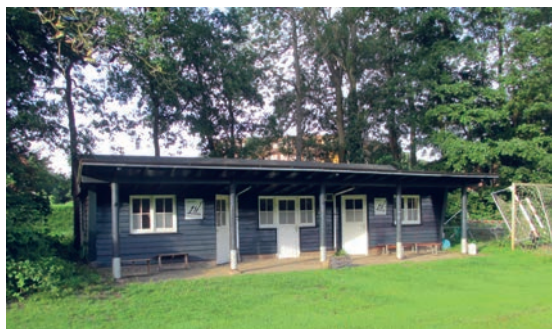
De kleedkamers van Edon in 2017. (Foto Harry Bouwhuis)
