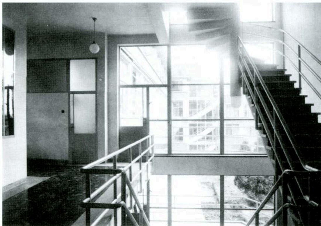
Interieurfoto van het trappenhuis van het Sophia Ziekenhuis. Op deze foto is de bijzondere 'hangtrap' te zien die als een wonder van betonconstructief vernuft aan het plafond hangt. Foto uit de publicatie van het gebouw in het architectuur-tijdschrift 'De 8 en Opbouw', september 1935. (Uit: Molema en Bak, Jan Gerko Wiebenga, Apostel van het Nieuwe Bouwen, 1987)
