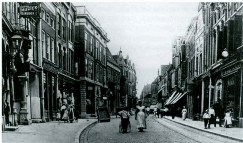
Een van de vele foto's van de Diezerstraat rond 1900. In 1905 kregen alle Zwolse straten het nu nog steeds gebruikte systeem van even en oneven huisnummers. Voor die tijd ontbrak die nummering of was ze systeemloos. (Collectie HCO)
