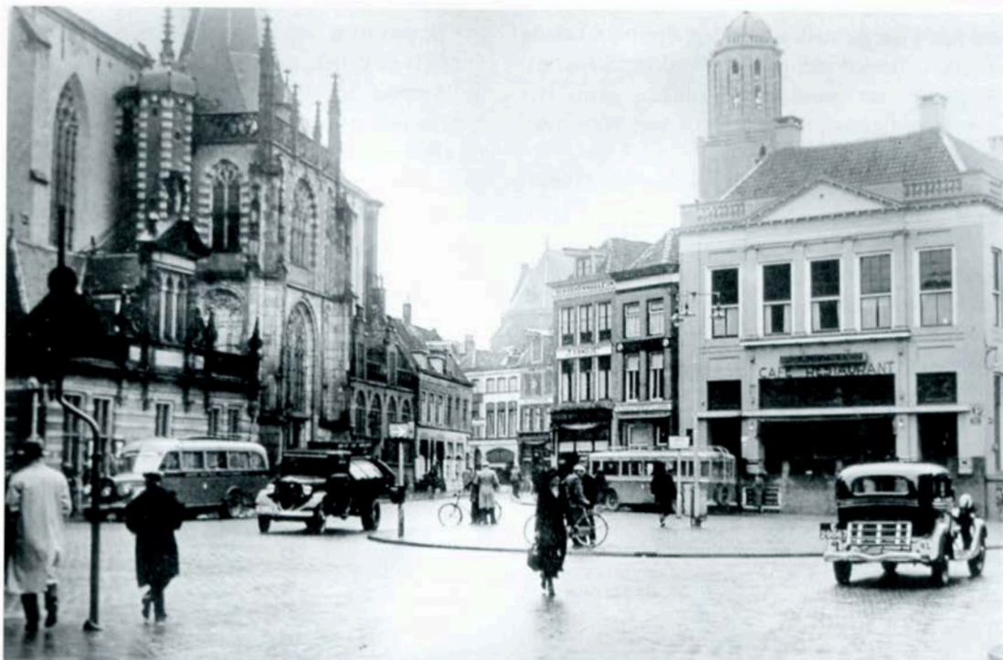
De Grote Markt eind jaren dertig met de in 1929 aangelegde rotonde. Voor De Harmonie was toen een bushalte. (Uit: 'Als de Dag van Gisteren', nr 4, Zwolle 1991)
