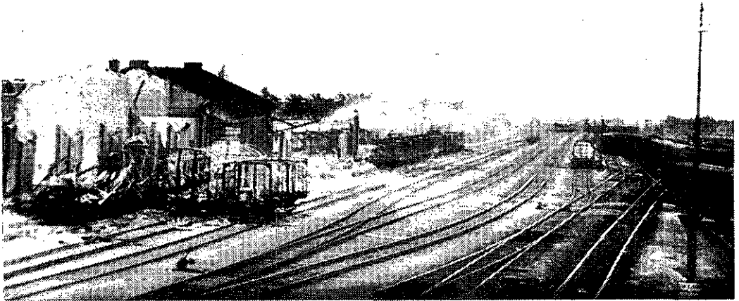
Afgebrande goederenloodsen op het Zwolse spoorwegemplacement, mei 1940
