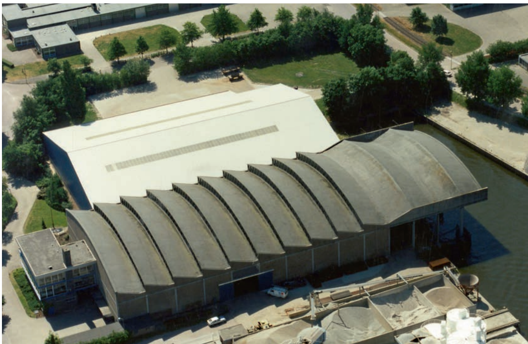
Luchtfoto van de IJzerleeuwwhal met de karakteristieke dakconstructie. Begin jaren negentig. (Bedrijfsarchief IJzerleeuw)
