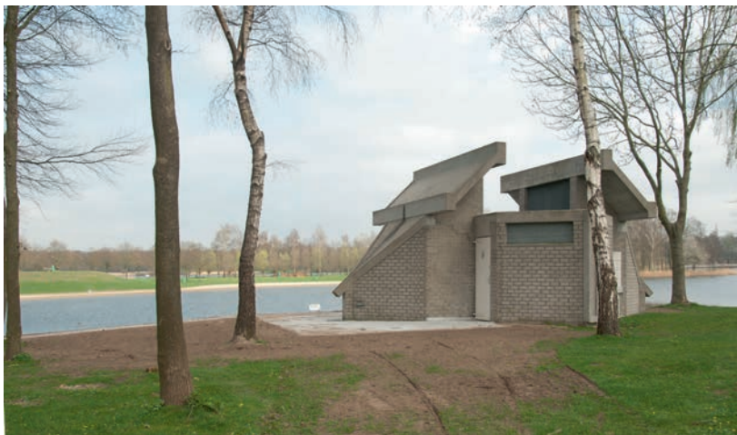
Betonnen toiletgebouw bij de Wijthmenerplas. (Foto Jan van de Wete- ring)
