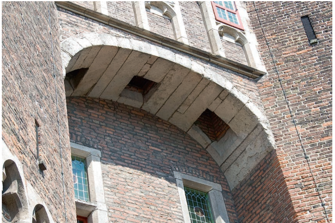
Mezekouw van de Sassenpoort. Door deze luiken konden de verdedigers van de stad pek of kokende olie op de vijand gooien. (Foto Jan van de Wetering)
