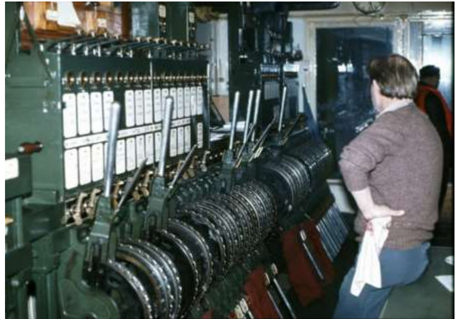
Bediening van seinen en wissels via trekdraden vanuit seinhuizen met handelinrichtingen van Siemens&Halske.
